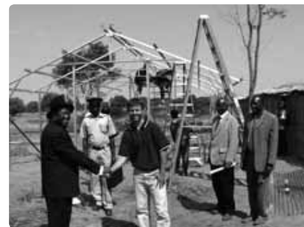
Sambia: Meiring Pretorius begrüßt den Dorfchef vor der Stahlkonstruktion, die die Kapelle und den Unterrichtsraum beinhalten soll.
