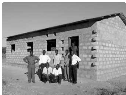
Kapelle im Rohbau, von Studenten errichtet
